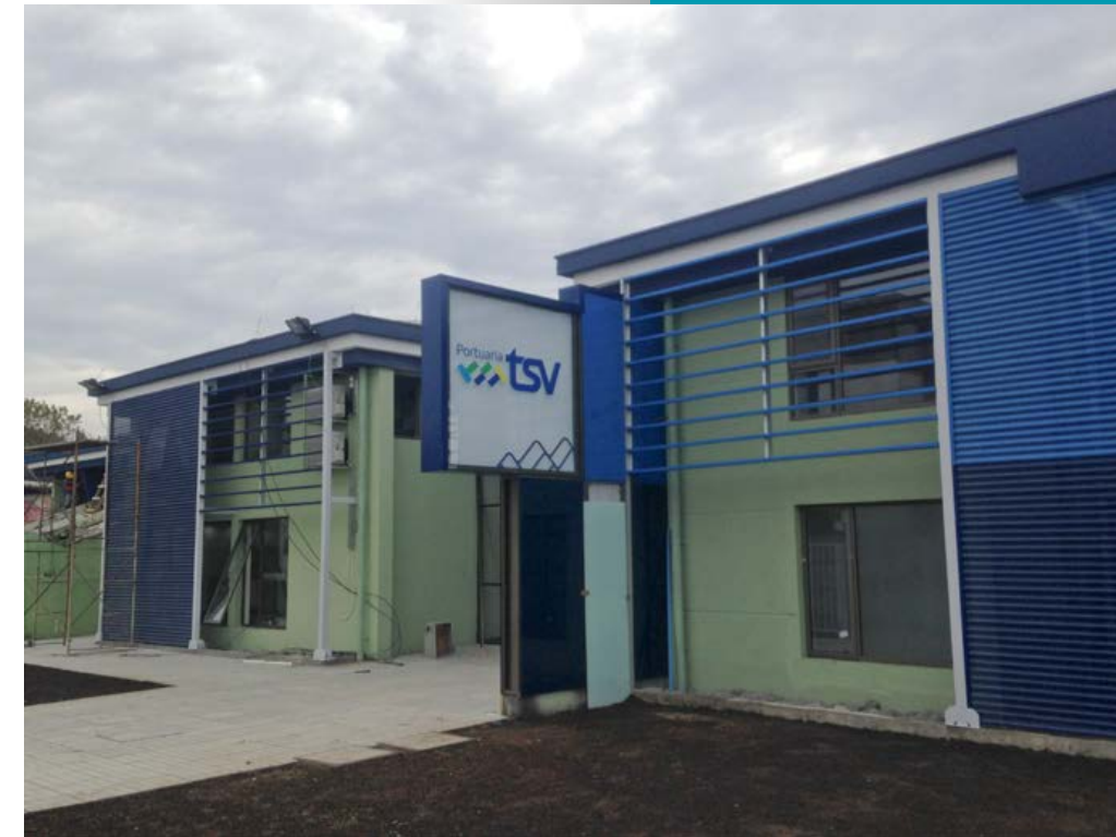
Oficinas corporativas Portuaria TSV en proceso de reconstrucción.
